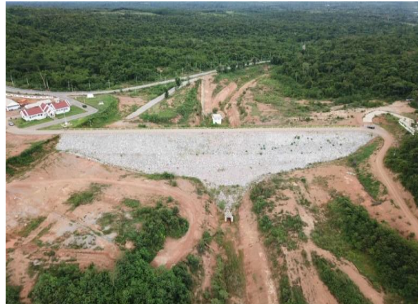
รูปที่ 1.6-1 ทำนบดินปิดช่องเขาต่ำและอาคารประกอบ
